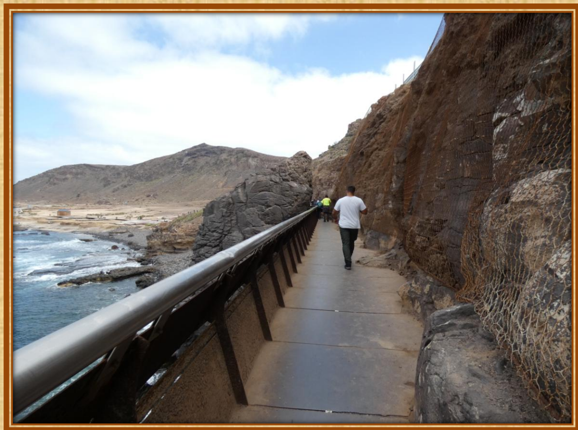
El acceso al Confital lo realizamos a través de una pasarela metálica.
