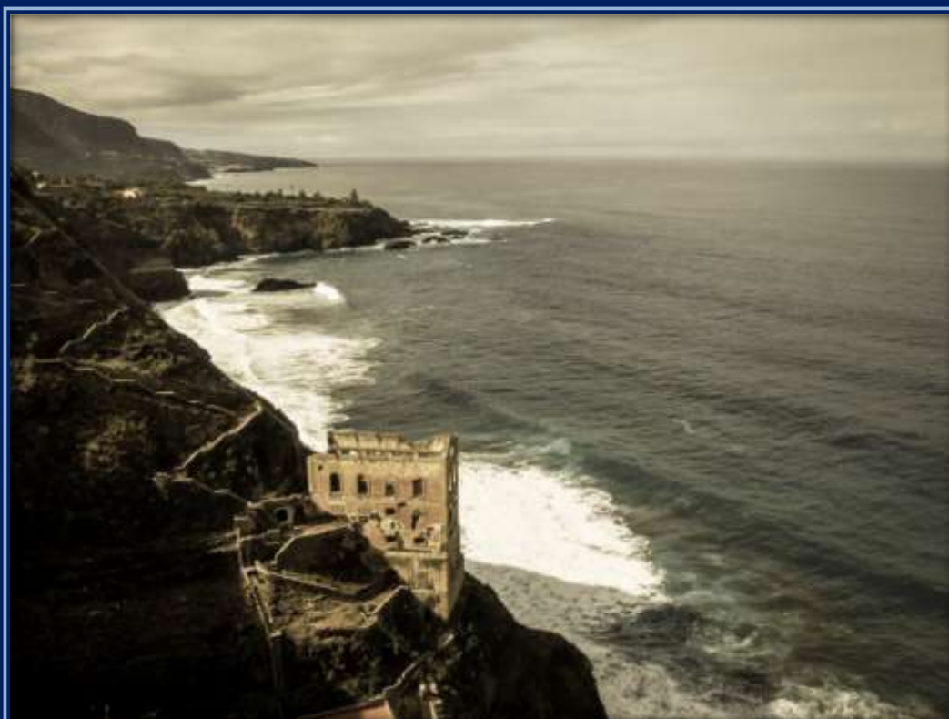
En este monumental edificio llamado La Gordejuela, se instaló la primera bomba de agua en el año 1903.
