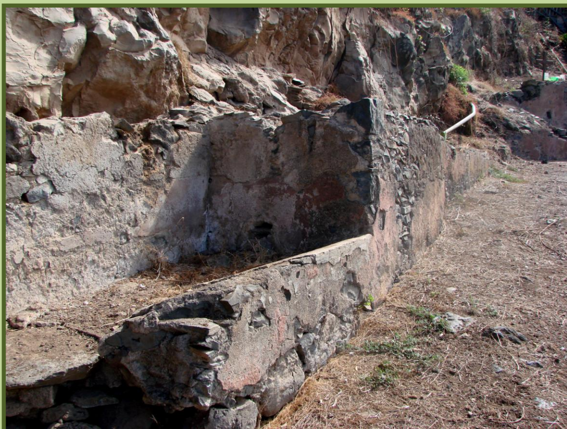
Al igual que el abrevadero, viejos lavaderos en estado de abandono.
