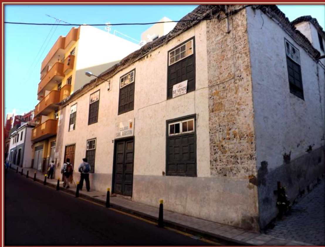
Casona histórica que albergó la vieja institución del colegio San Agustín en estado de abandono
