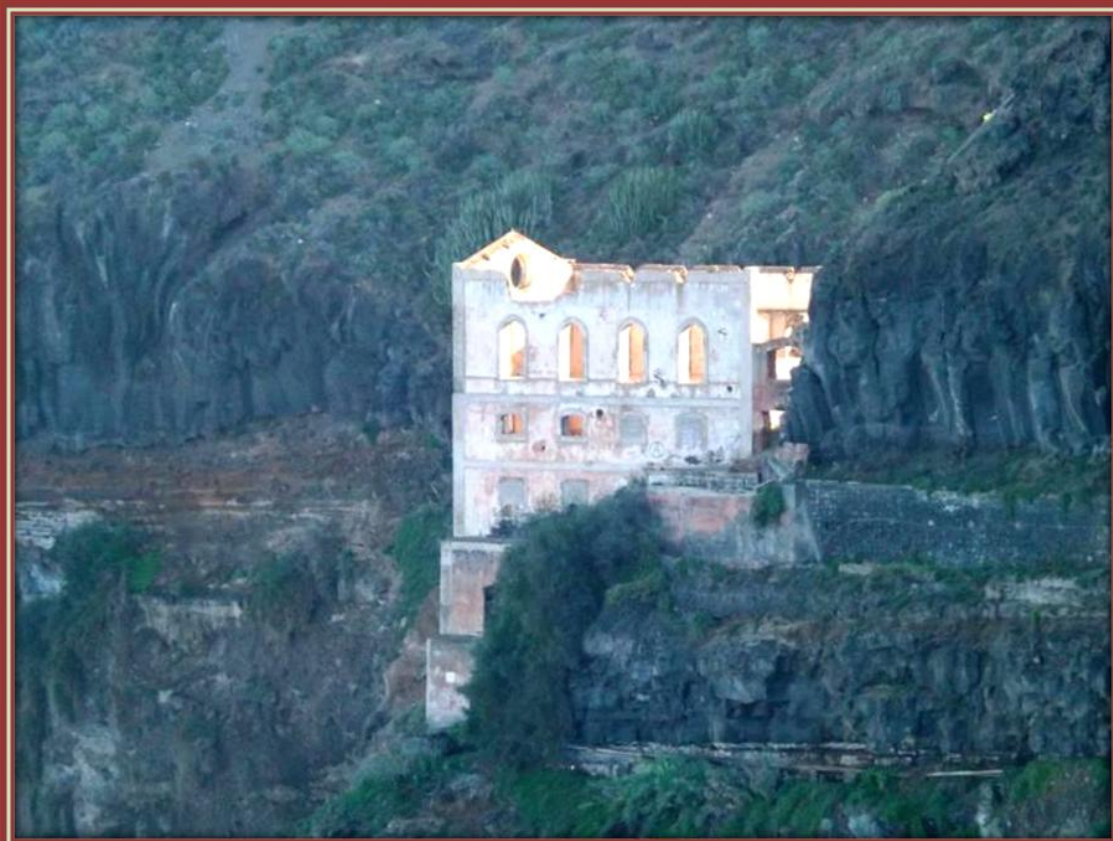
Vivienda en ruinas. En este lugar se encontraba la máquina elevadora de aguas de La Gordejuela
