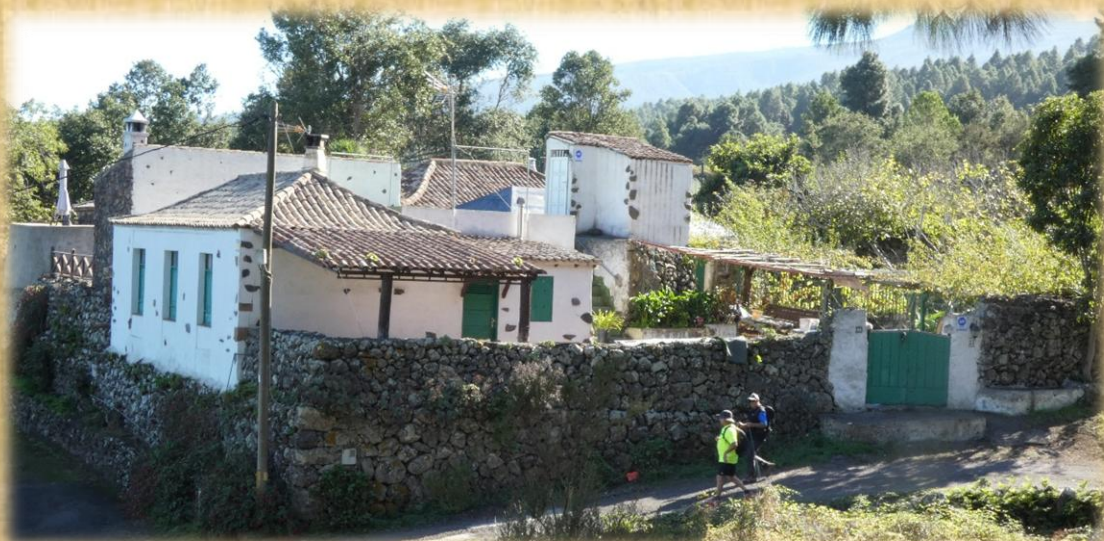
Muchas casas rurales se encuentran en muy buen estado de conservación
