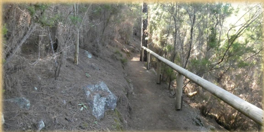
El último tramo del sendero se encuentra protegido con barandas de madera.
