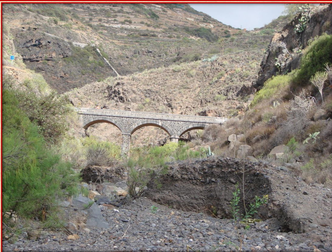
El puente desde el cauce del barranco
