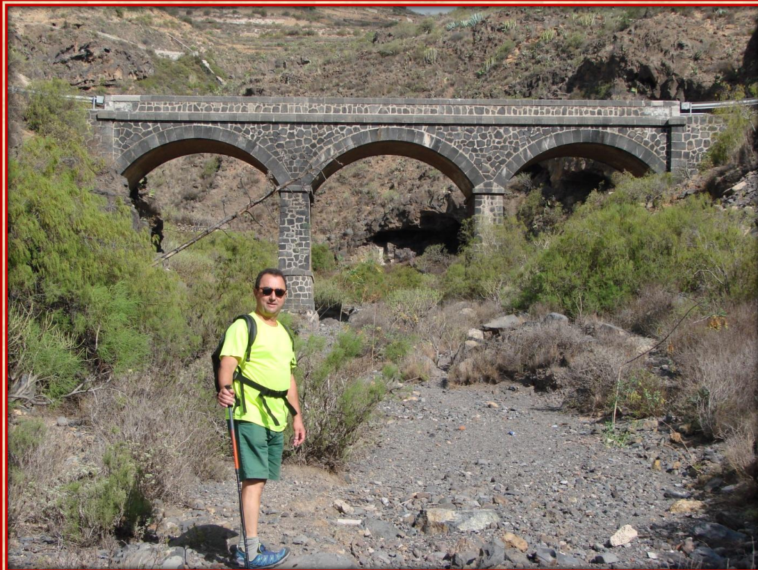
Puente de tres ojos en la C-822 (Vieja carretera general)
