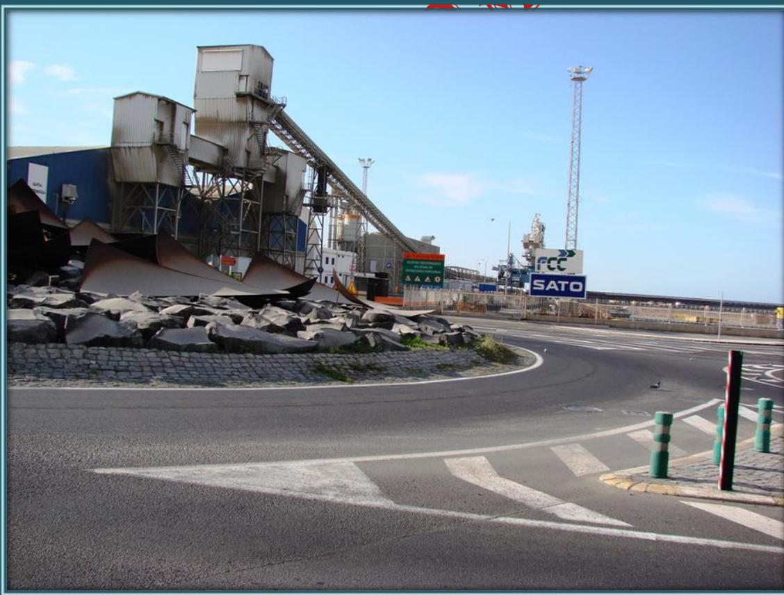
*A través de esta cinta el material para la fabricación del cemento que se descarga en el puerto llega a la fábrica.*
