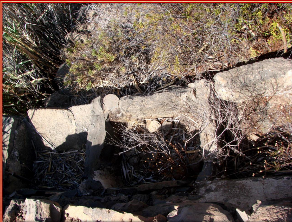
En la parte baja del aljibe se encuentra este abrevadero o lavadero en estado de abandono.
