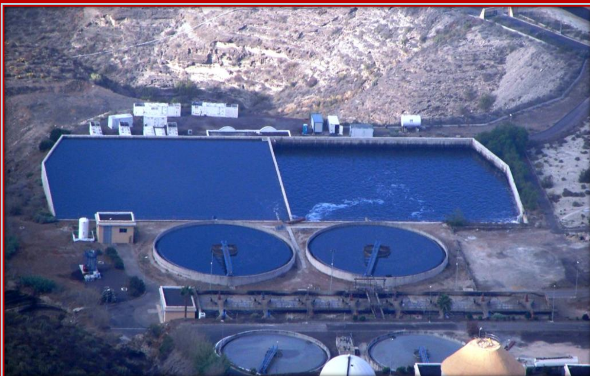
Una gran depuradora que recoge las aguas de la zona.
