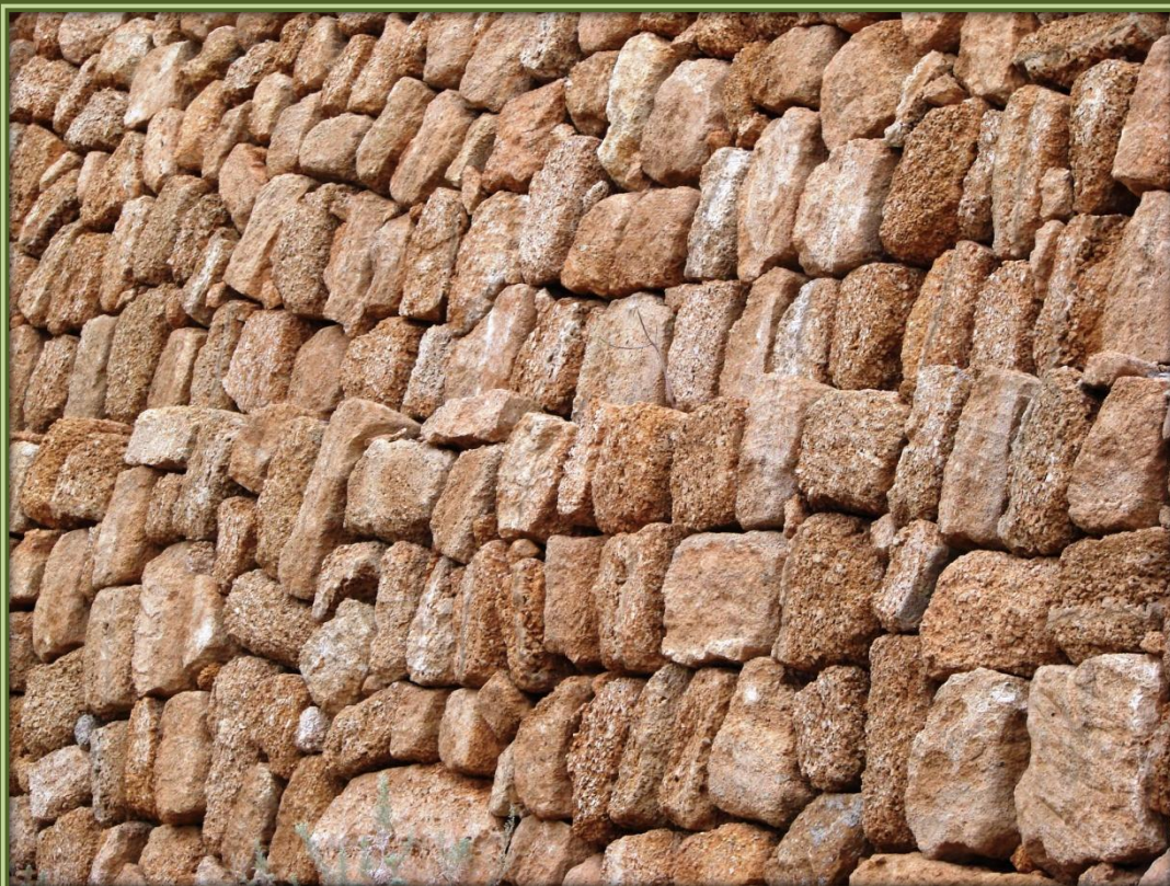
Nos llama la atención la excelente construcción de este muro.
