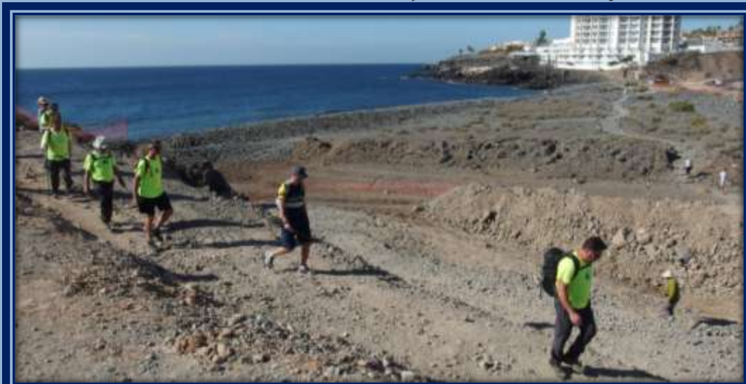
En las inmediaciones del complejo hotelero de San Blas nos encontramos con obras que afectan a la playa.
