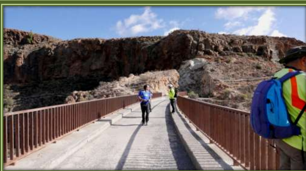
Paso de la zona alta de la presa.
