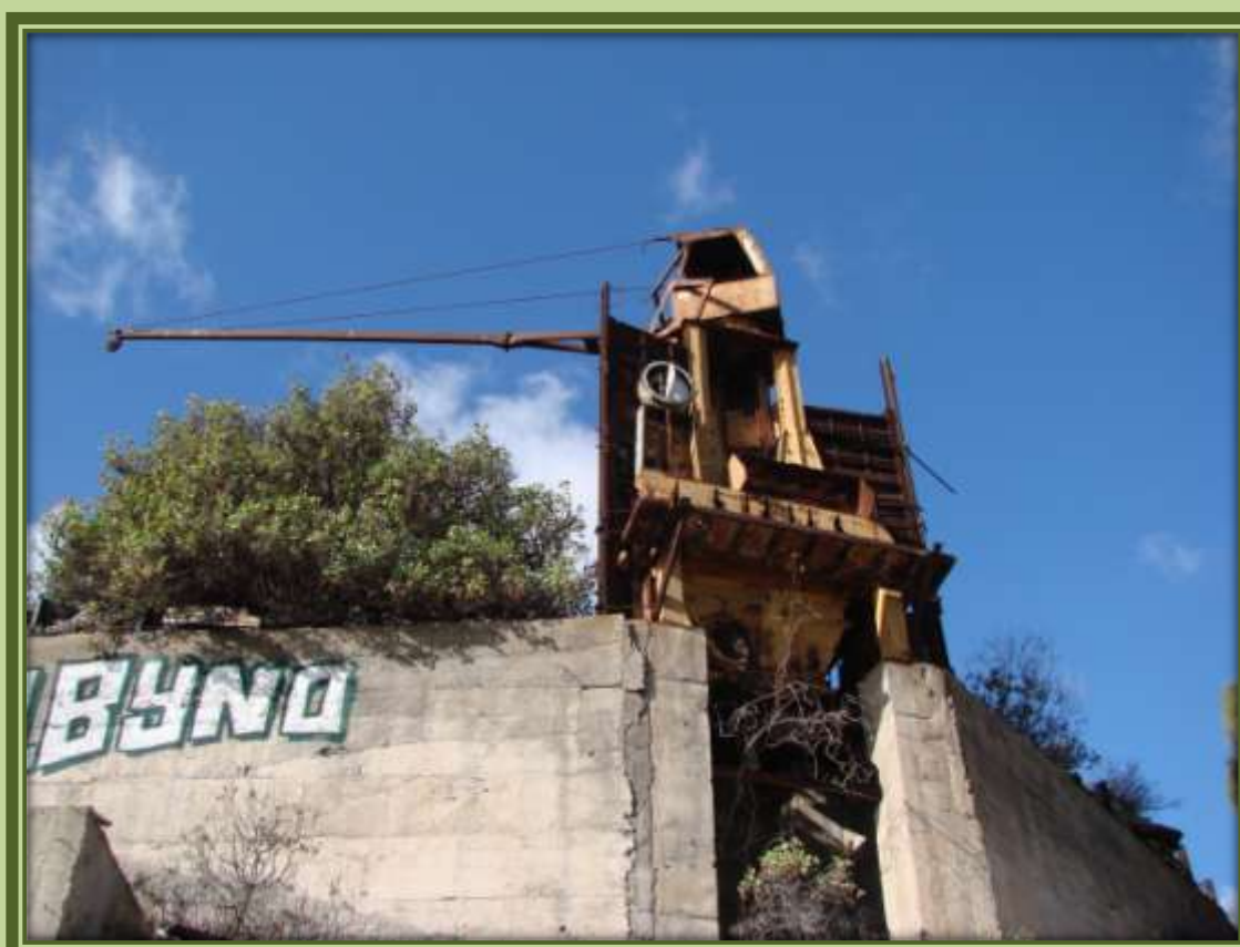
Vieja grúa utilizada en la construcción de la presa
