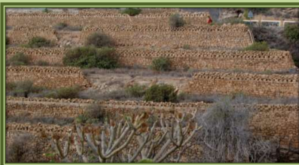
Bancales contruidos por la piedra tosca, muy presente en el sur de la isla.
