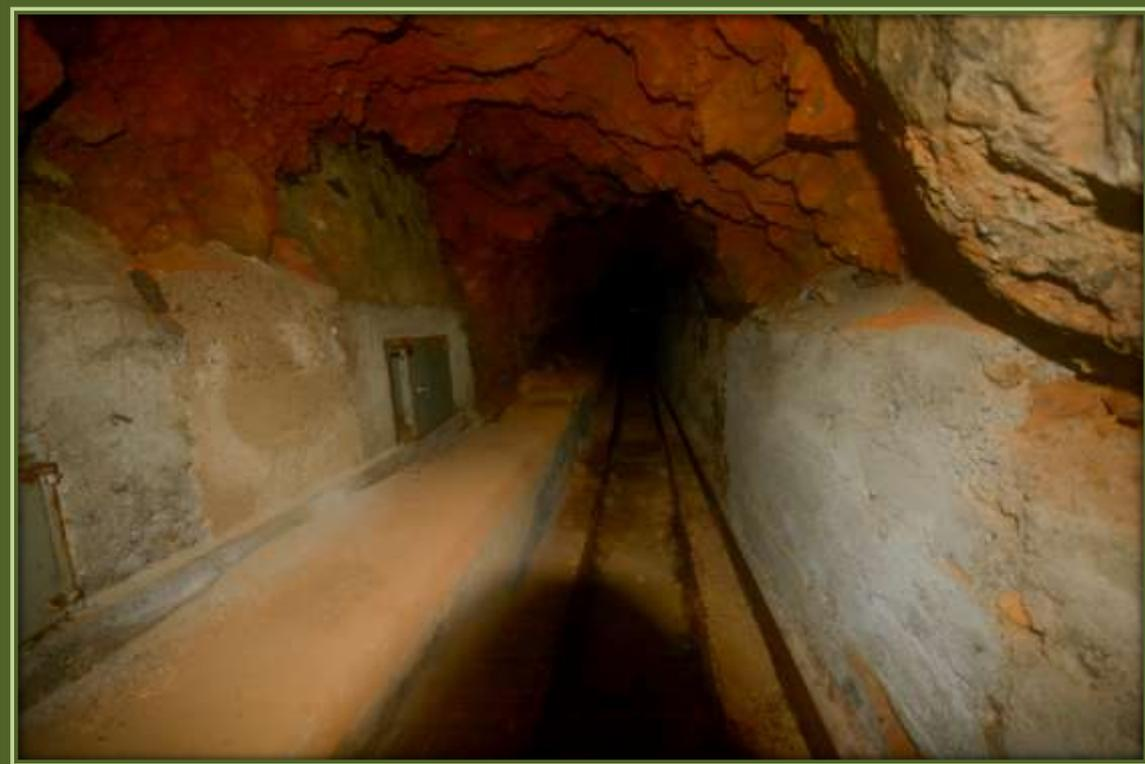
*A la izquierda podemos apreciar el canal y las dos cajas de fuerte que se utilizaban para custodiar el explosivo.*
