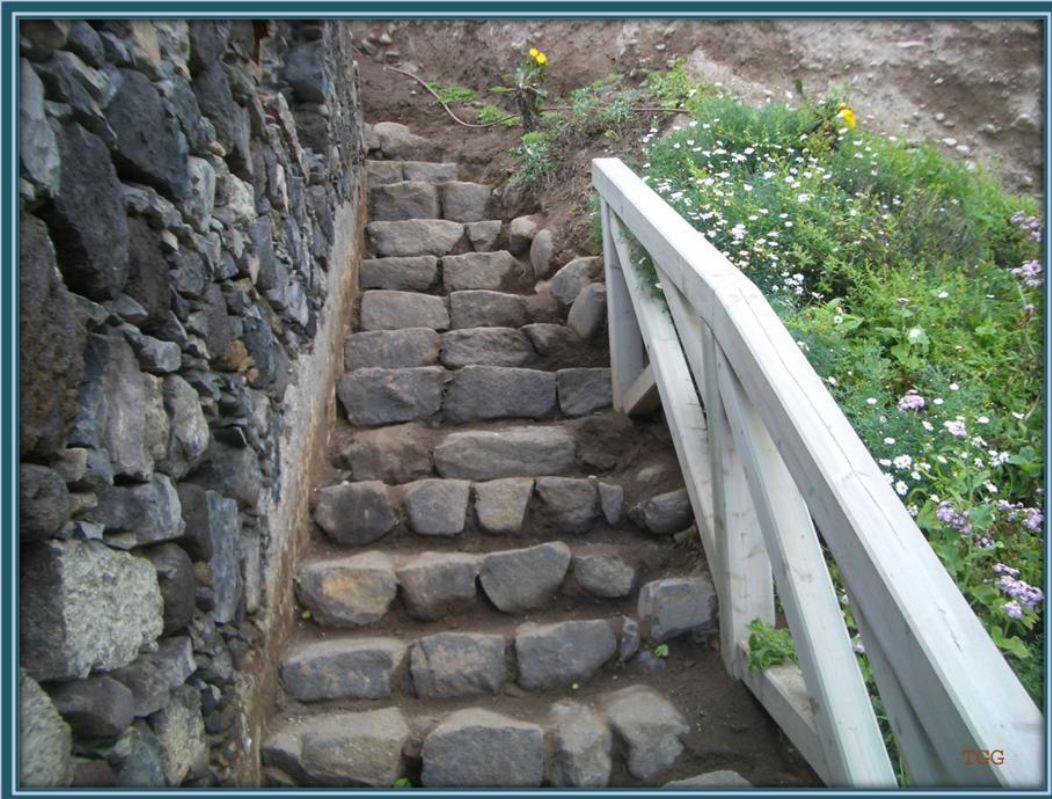
Ascendemos por estas escaleras en perfecto estado de conservación que rodean la casa del elevador de agua.
