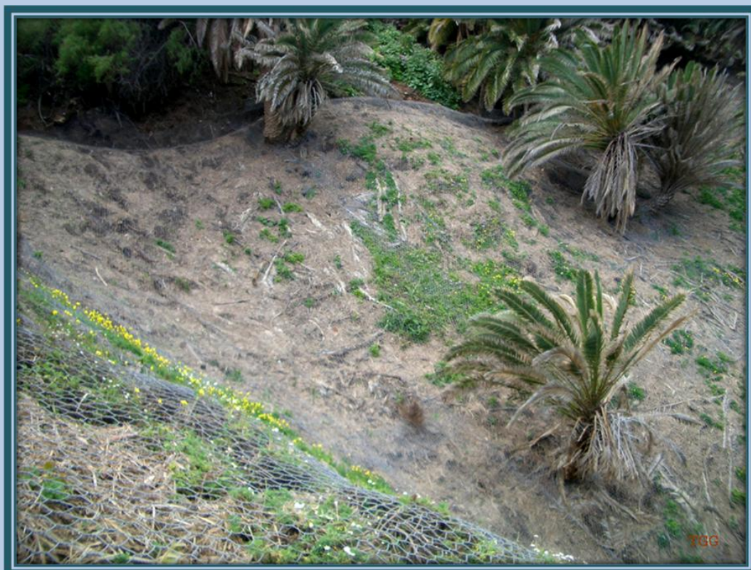
Se han colocado mallas metálicas para proteger a los caminantes de los posibles riesgos de desprendimientos que se puedan ocasionar.
