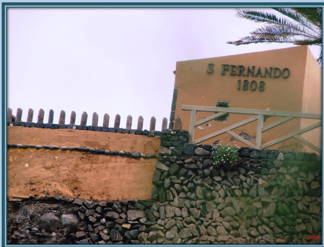
Al subir desde el túnel llegamos al fortín de San Fernando que data de 1808.
