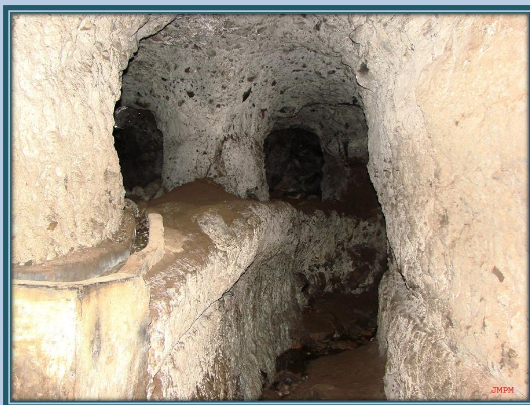
Diversas galerías conectan con el túnel principal por donde estamos cruzando. ¿Sabes que en Tenerife hay tantos kilómetros de galerías como la distancia que separa Canarias de la Península Ibérica?
