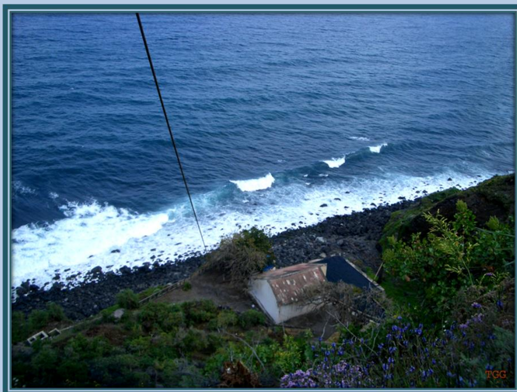
Se puede apreciar como el cable del güinche llega a la caseta que se encuentra en la playa.
