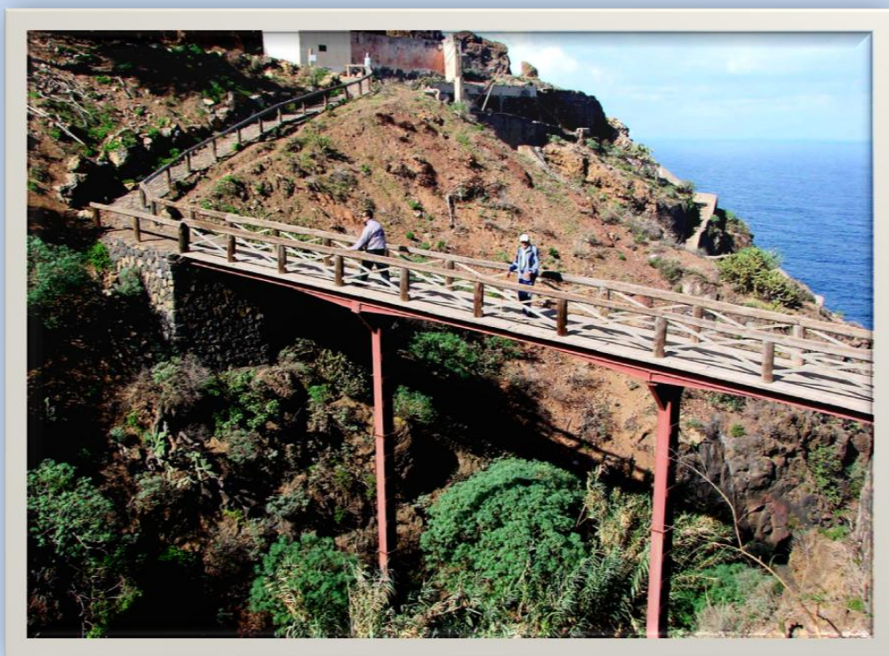
Puente sobre el barranco de Castro.
