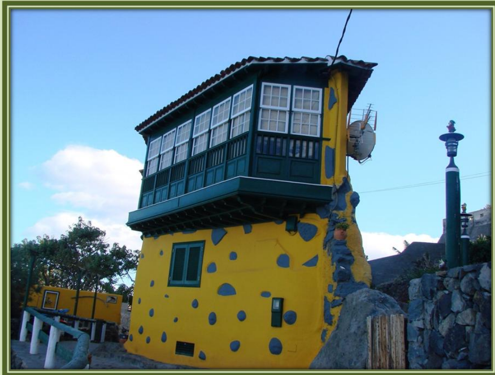
Casa del siglo XIX denominada Casa del Halcón. Remodelada recientemente.
