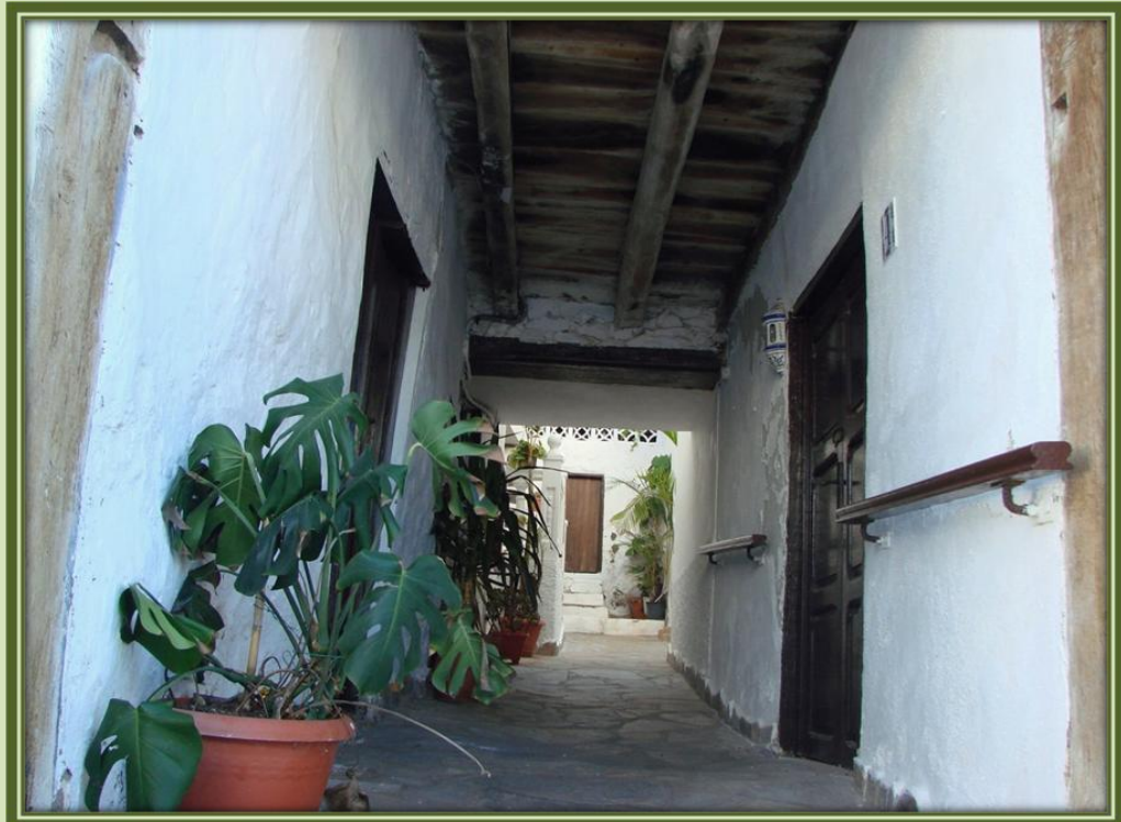
Entrada al viejo caserón denominado el Convento, se encuentra en buen estado de conservación aunque con numerosas modificaciones; en el viven varias familias.
