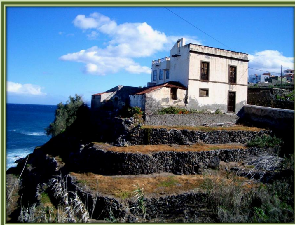
La vivienda del conde pertenece hoy en día a doña Juana López. Como se observa se encuentra en muy mal estado. El lugar es ideal para recuperar y transformar la vivienda en un pequeño hotel rural ya que el paisaje, la tranquilidad...son indescriptibles.
