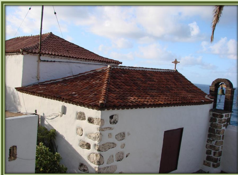
Lateral de la ermita donde se aprecia una pequeña espadaña de cantería con una campana. La planta de la ermita es rectangular con una pequeña sacristía que forma parte de la vivienda. En el altar mayor se encuentra un cuadro de la Virgen del Rosario.
