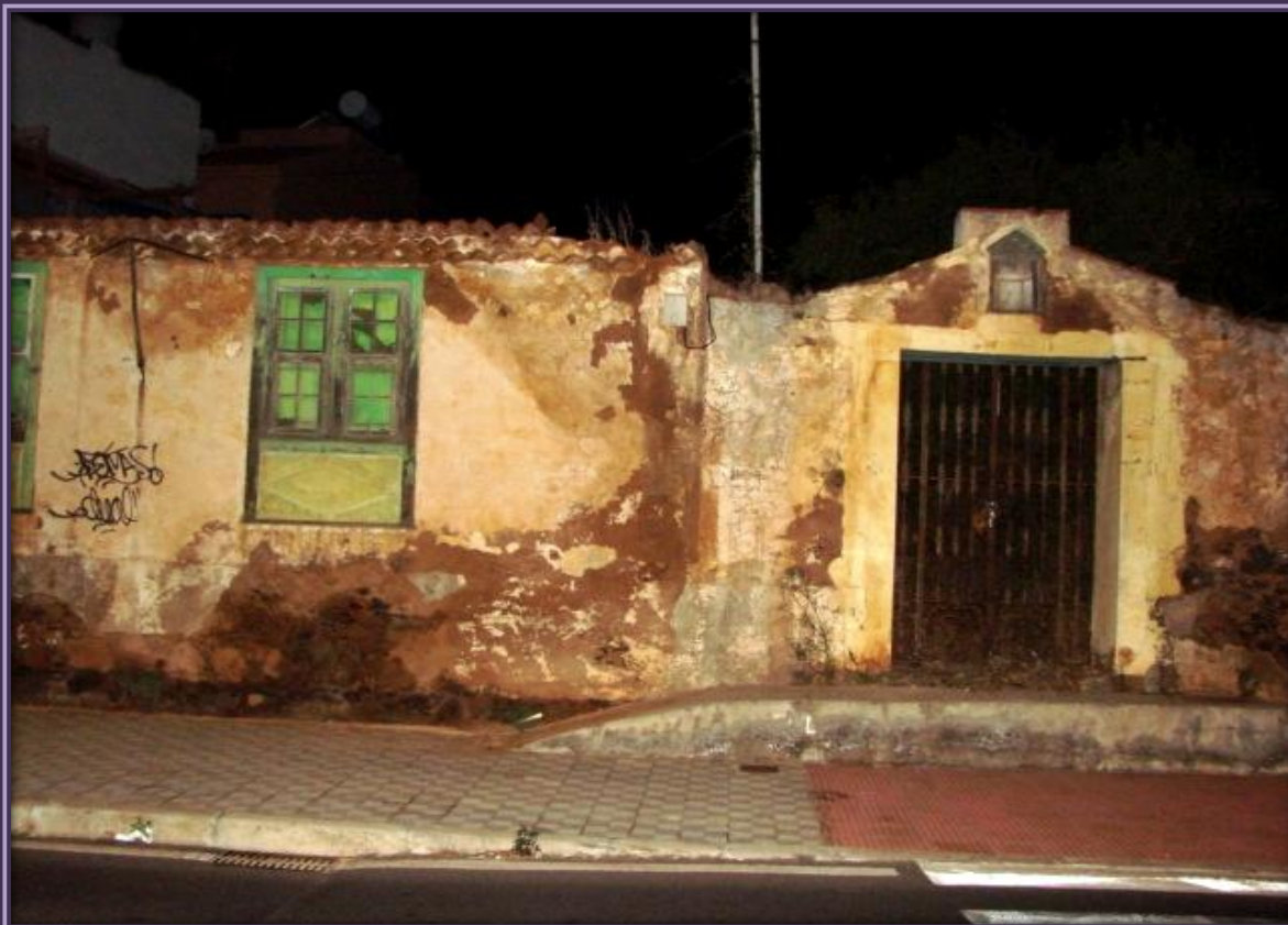
En el transcurso del camino nos encontramos con numerosas viviendas en estado lamentable.
