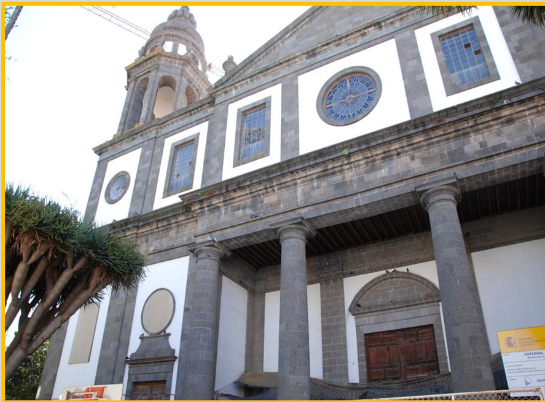
Catedral de La Laguna (en obras). Lugar de partida.
