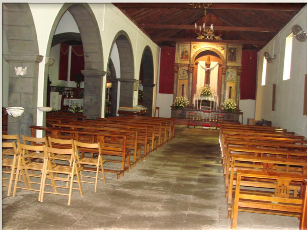
Interior del Santuario, observamos como el piso está realizado con losa chasnera.
