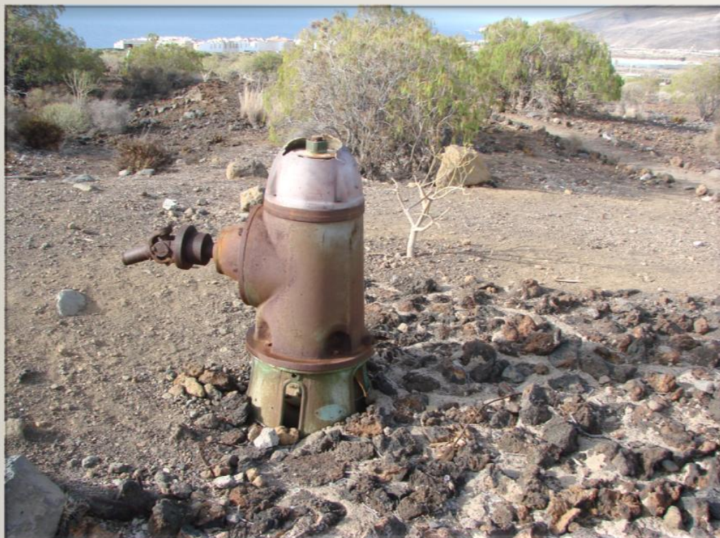
Cerca de la zona urbana del Puertito encontramos un depósito de agua con una bomba.
