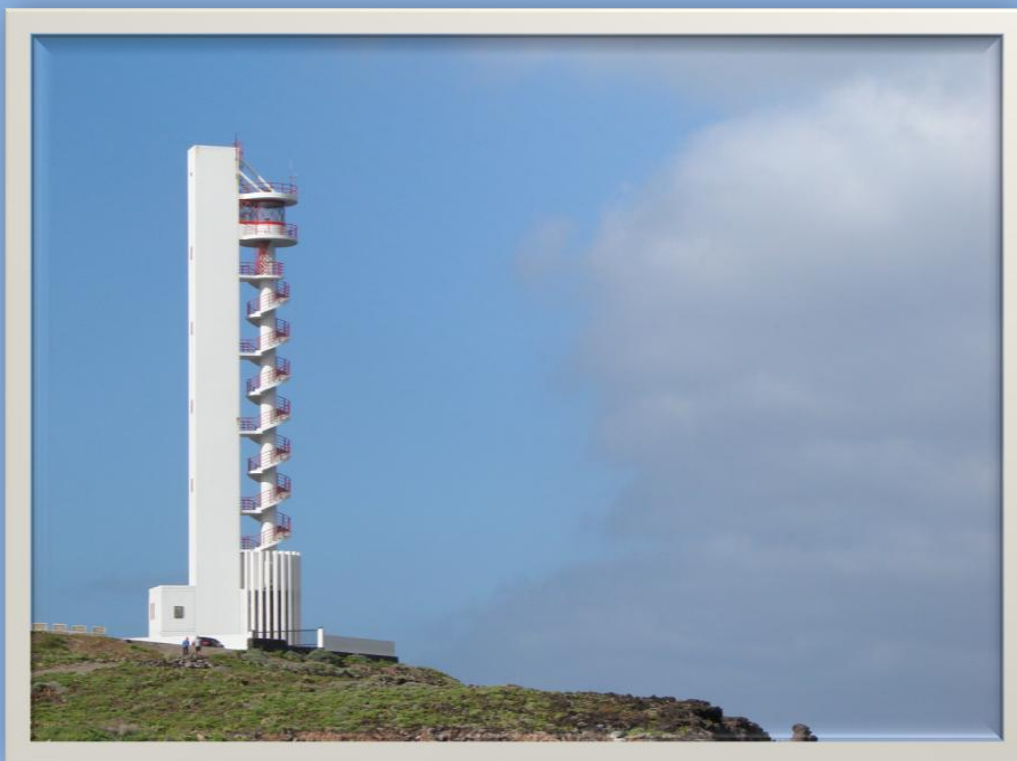
Faro de Buenavista del Norte. Su construcción se llevó a cabo en el año 1991, se caracteriza por una torre cilíndrica con una escalera en espiral.
