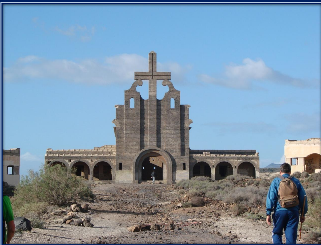
La fachada de la iglesia tiene el estilo de la arquitectura franquista.
