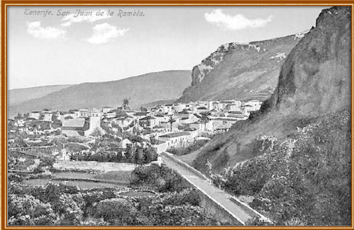
Antigua vista de San Juan de la Rambla. / FEDAC Antigua vista de San Juan de la Rambla
